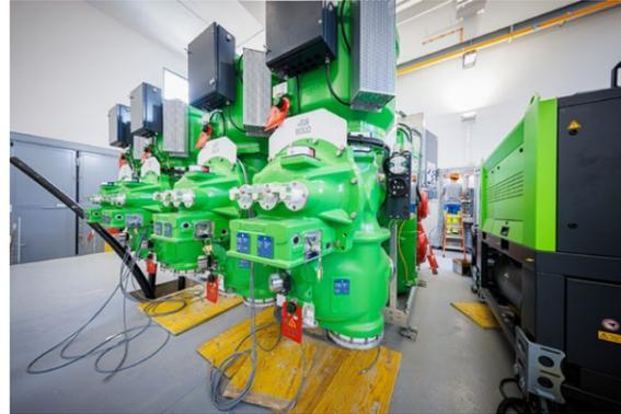
**La nouvelle installation utilise un gaz alternatif, appelé g3, qui réduit de plus de 99 % l'équivalence CO<sub>2</sub> par rapport à une installation traditionnelle au SF6 de même taille.**
