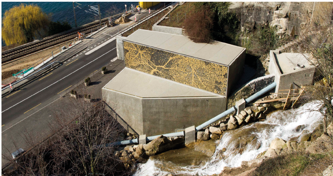
Petite centrale hydraulique de Rivaz, au fil de la rivière du Forestay (VD)
