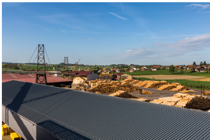
Centrale de biomasse Enerbois, à Rueyres (VD)
