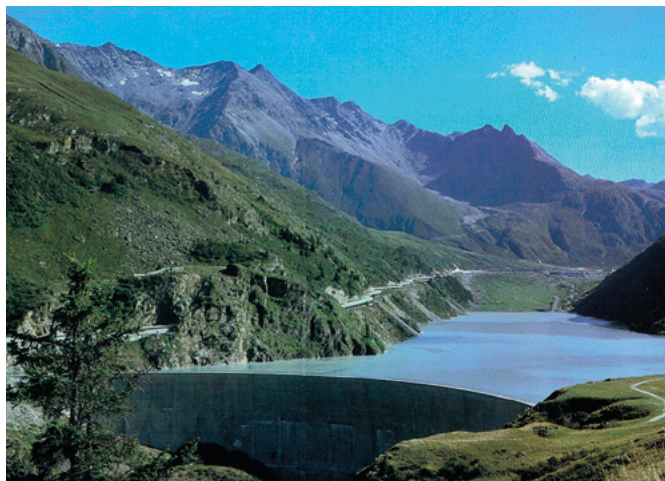
Barrage de Bourg-St-Pierre (VS)
