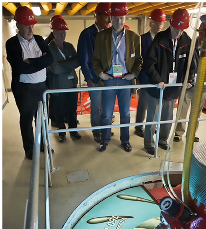
Une turbine de la Centrale des Clées
