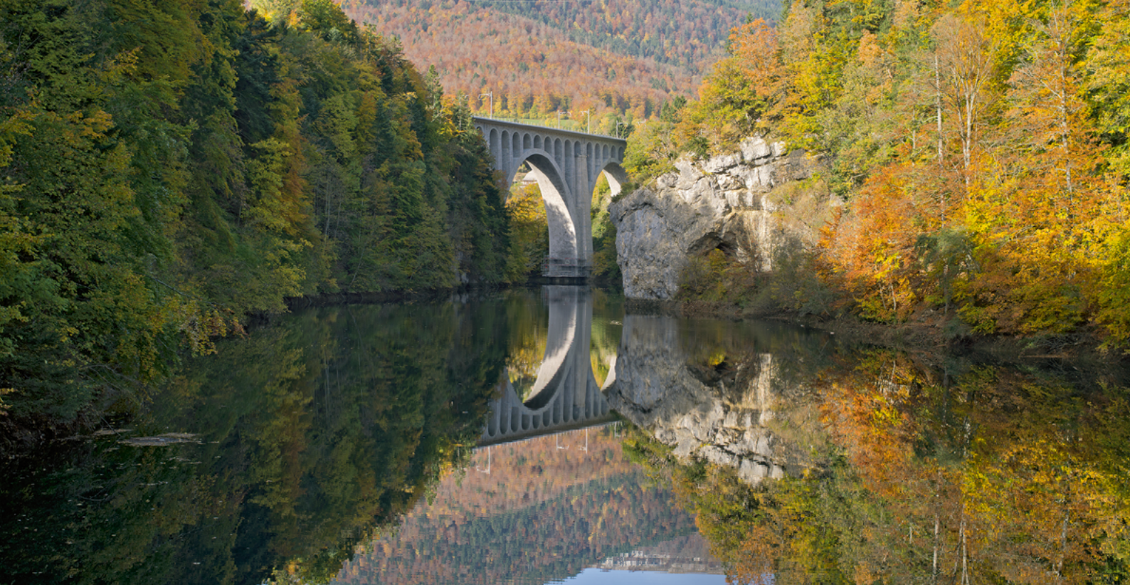
Le barrage du Day, sur le lac du Miroir, situé en amont de la Centrale des Clées (VD)
