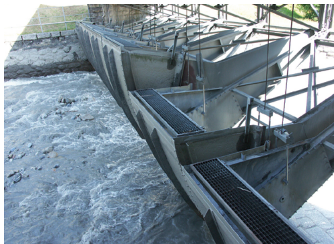
Centrale au fil de l'eau de Sembrancher (VS)
