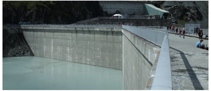
Le Barrage de Bourg-Saint-Pierre (VS) fait aussi office de pont
