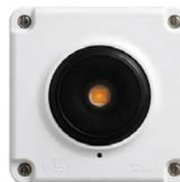
Interrupteur IPX0 installé dans le volume 2 au lieu d'un IPX4
