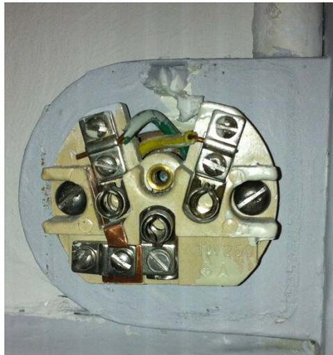
PE sous tension suite à réfection partielle de l'installation (croisement dans boîte de dérivation + absence de contrôle).
