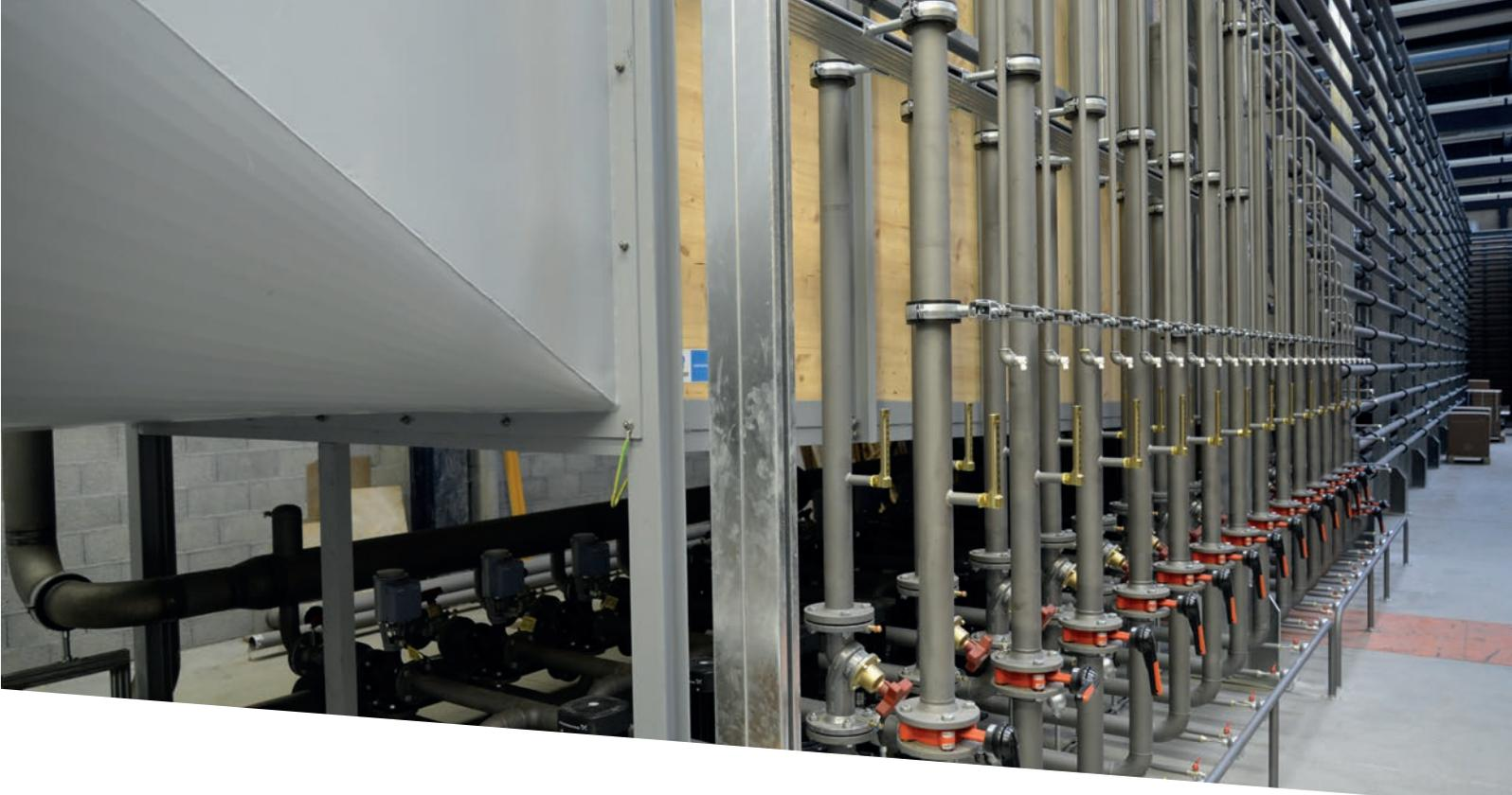
Réseau de distribution d'eau glacée (-15°) pour le refroidissement du « Wind tunnel », utilisé pour la recherche sur l'éolien.
