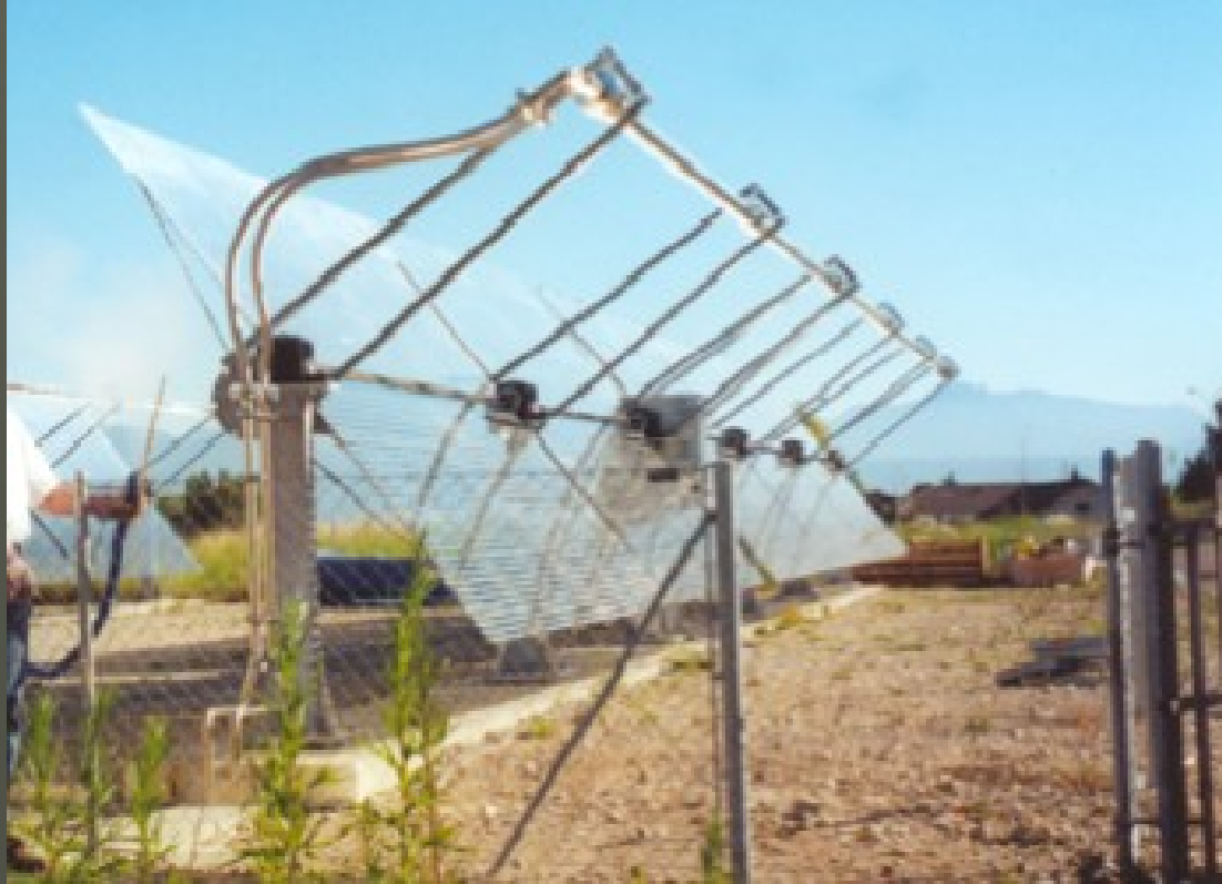
CEP: Unité fondamentale de la centrale solaire thermodynamique
