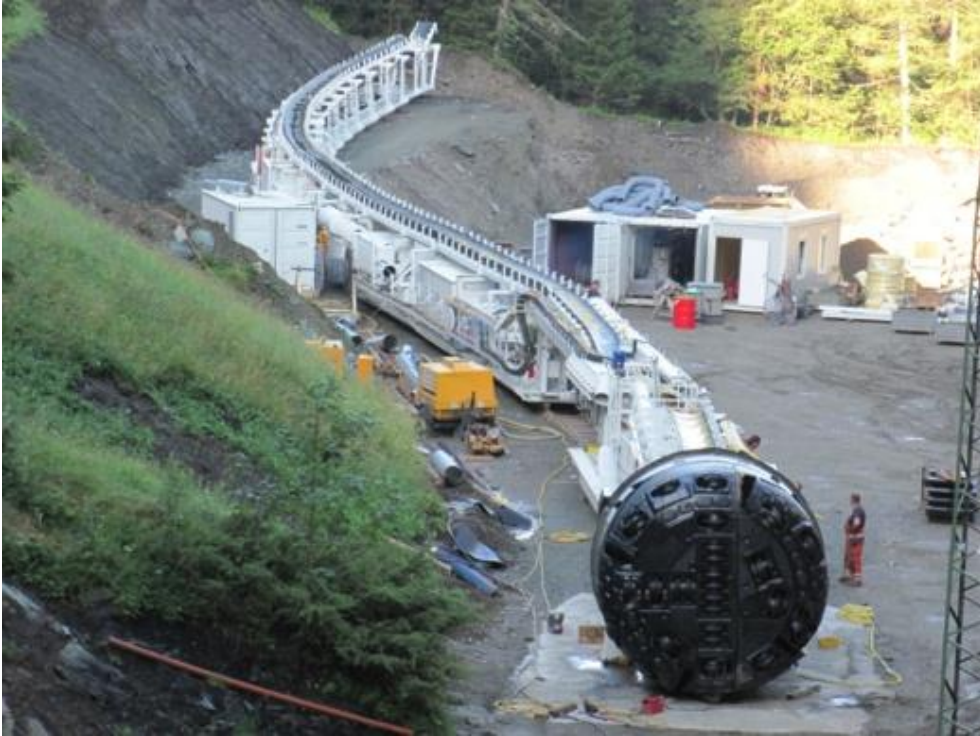
Tunnelier © Romande Energie
