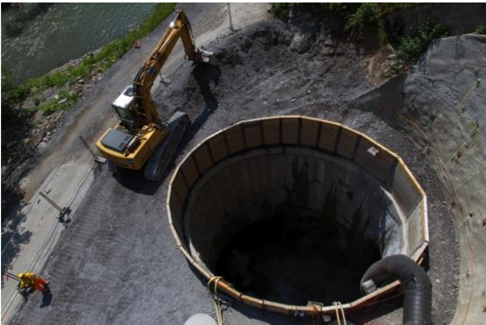
Chambre de mise en charge © Romande Energie
